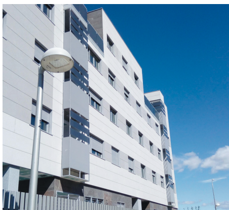
Proyecto gestionado por Acerta el “Ensanche de Barajas”, Madrid.
